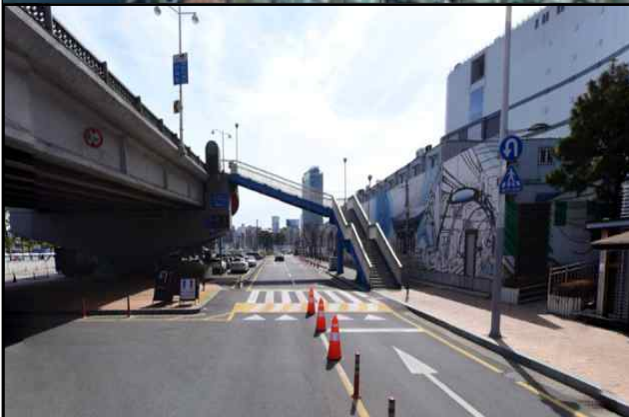
롯데백화점측 E/V 설치대상지 전경
